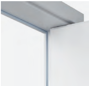
Roh zárubně z vnitřní strany
